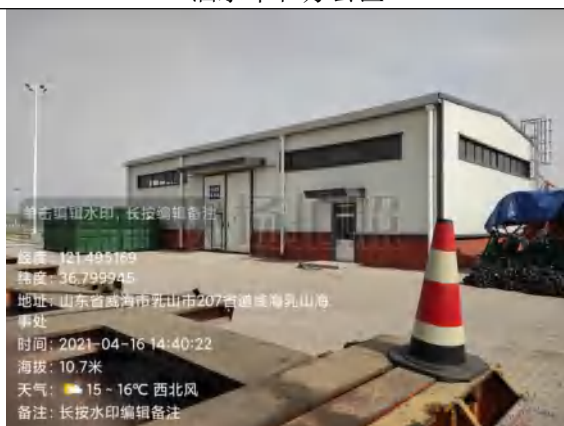
溢油应急设备仓库
