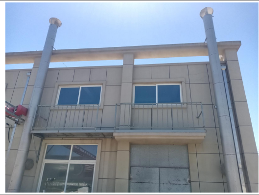
蒸气锅炉排气筒
