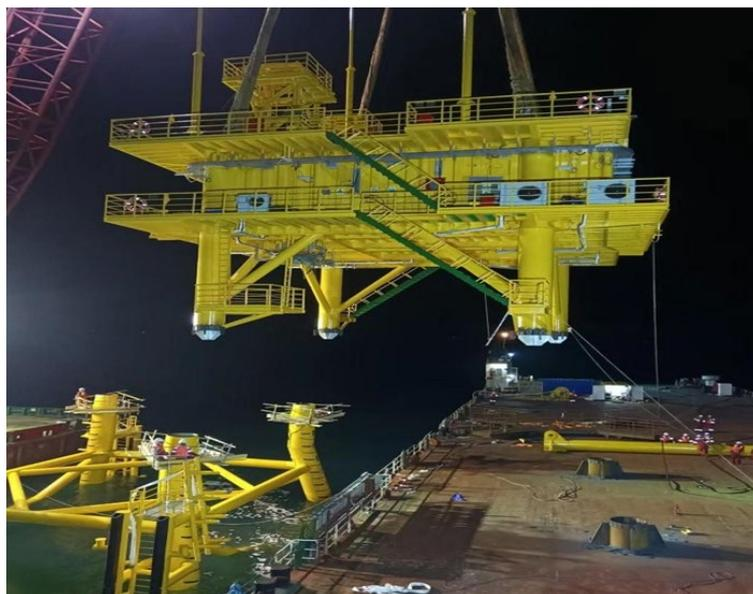
图 1.4-6 上部组块吊索具悬挂示意图
