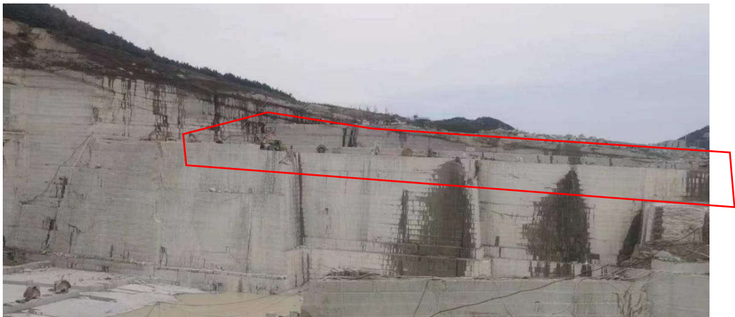
照片 3-2 治理区边坡照片（从西向东拍摄）
