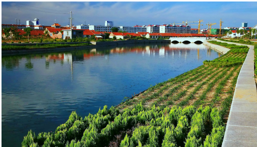
6 月 12 日,城南河整治工程完工
