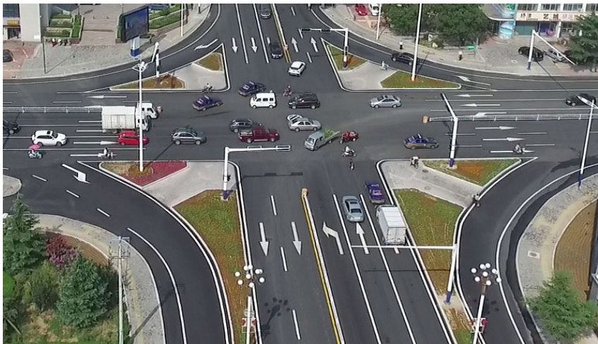
11月20日,笙歌路口渠化改造工程完工
