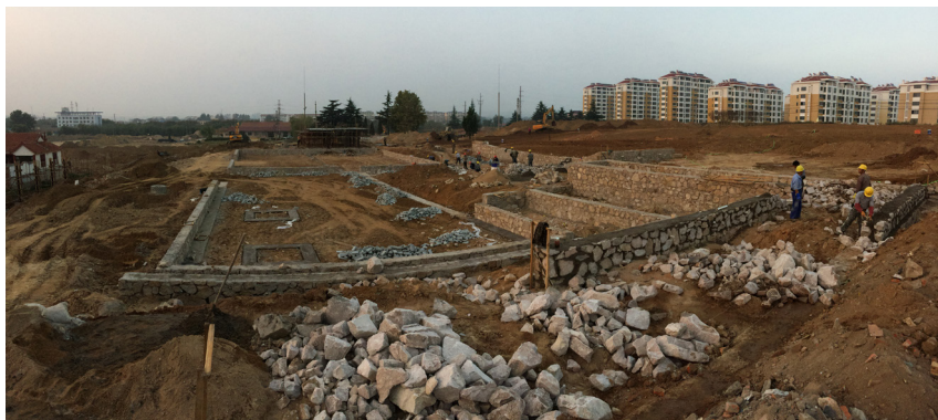
11月12日，金睛岭体育公园开工建设
