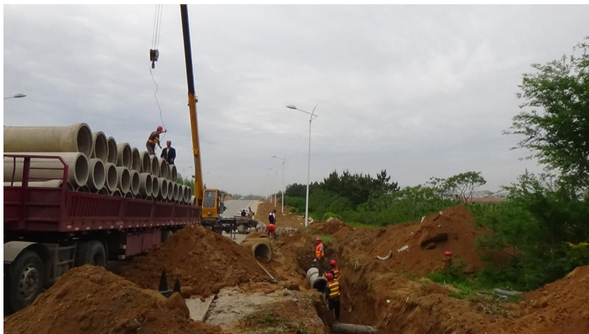
5月22日,天津路东段道路改造工程现场
