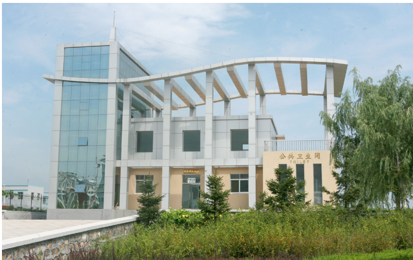
6 月 28 日,浦东南侧改造后的公厕投入使用
