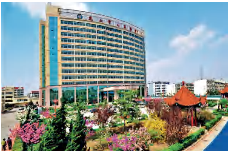
2008年4月23日，乳山市正华公司施工的市人民医院综合楼被评为“山东省建设工程优质结构杯奖”
