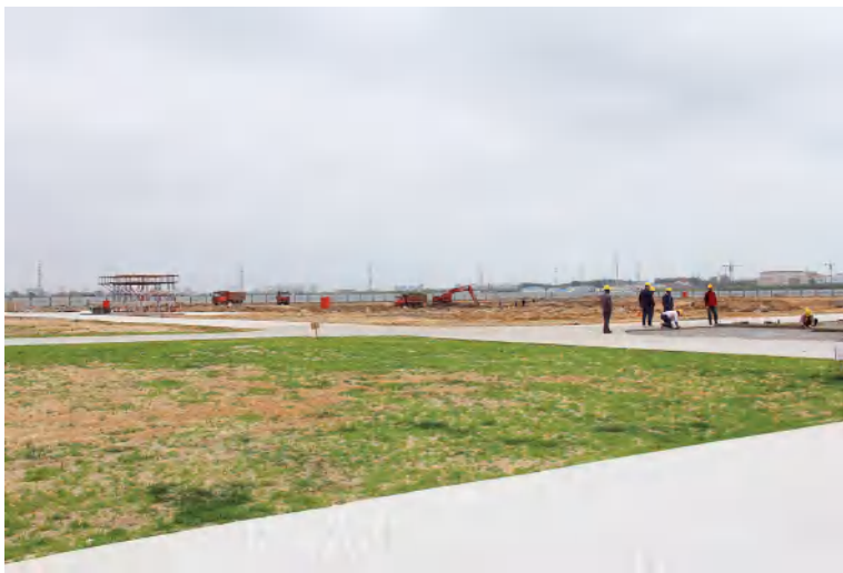
2015年5月，海湾新城——科技规划展示中心施工现场 (海湾新城提供)
