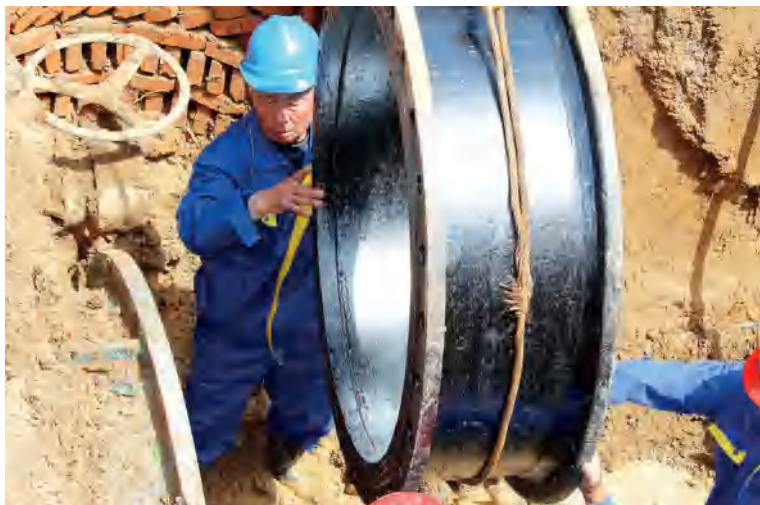
2007年5月2日，乳山市区至银滩输水管线改造施工现场 (水务集团提供)
