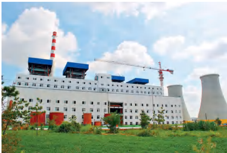
2015年10月24日，乳山市热电厂新增供热项目土建工程竣工（孔俊娟摄）
