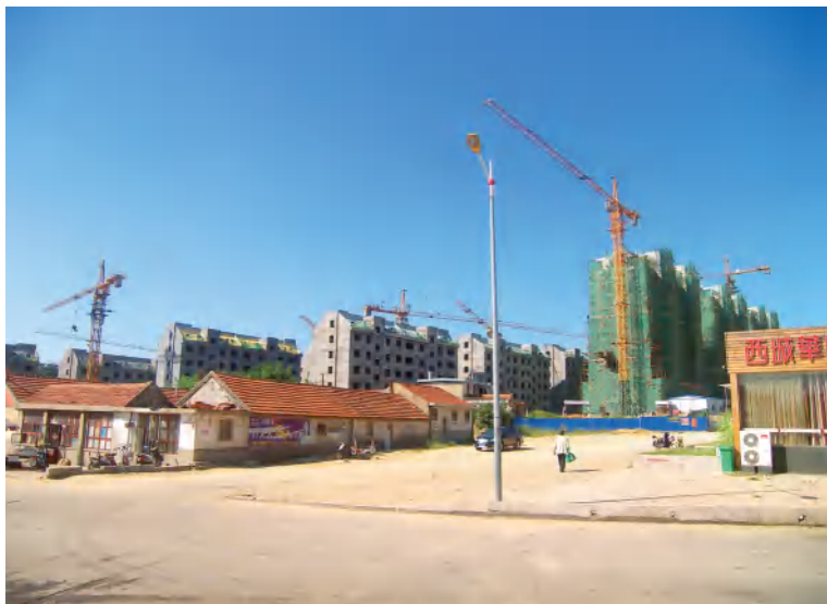
2013年5月,城区街道夏北村旧村改造现场
