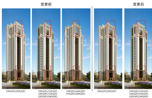
1) 北立面连廊钢结构造型柱取消
