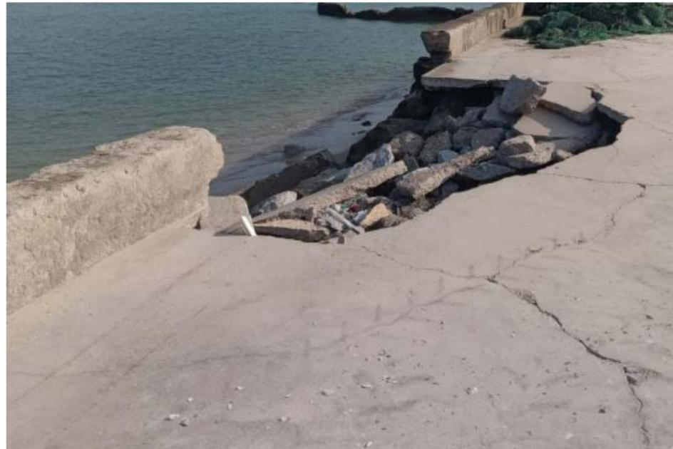
图 2.5-11 和尚洞渔港进港路破损图
