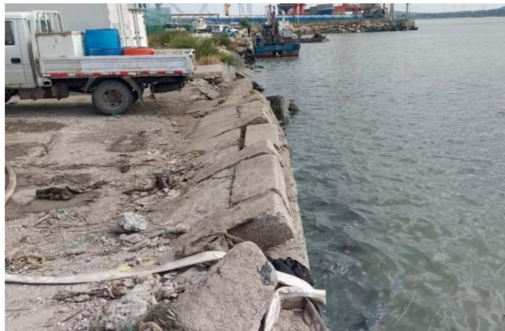
图 2.5-7 乳山口渔港北港区现状码头结构变形位移
