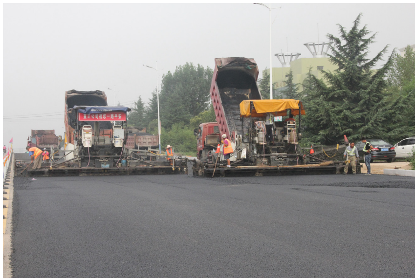
7 月 11 日，省道 202 迟家河桥至炉上桥段大修工程施工现场（交通局提供）
