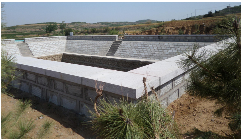
5月29日，财政投资扶持三甲村水利设施项目建成（石立委提供）
