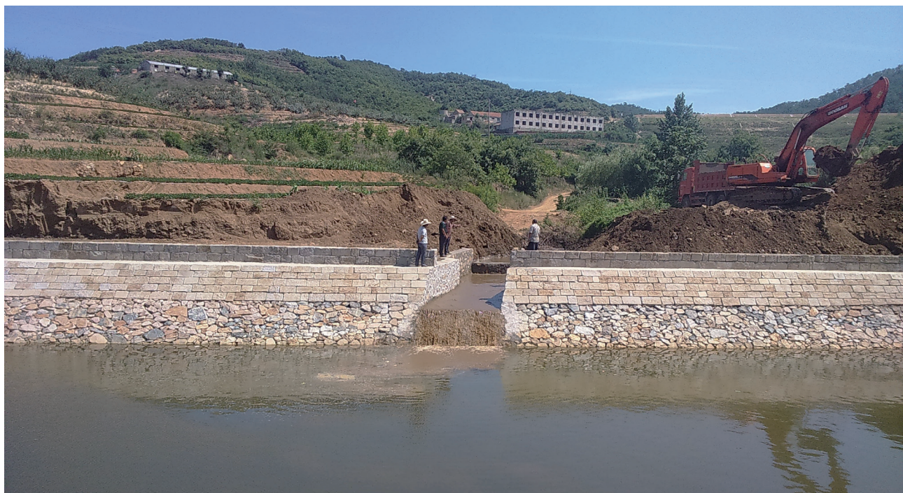
8月12日，下初镇上初村小型农田水利项目县工
