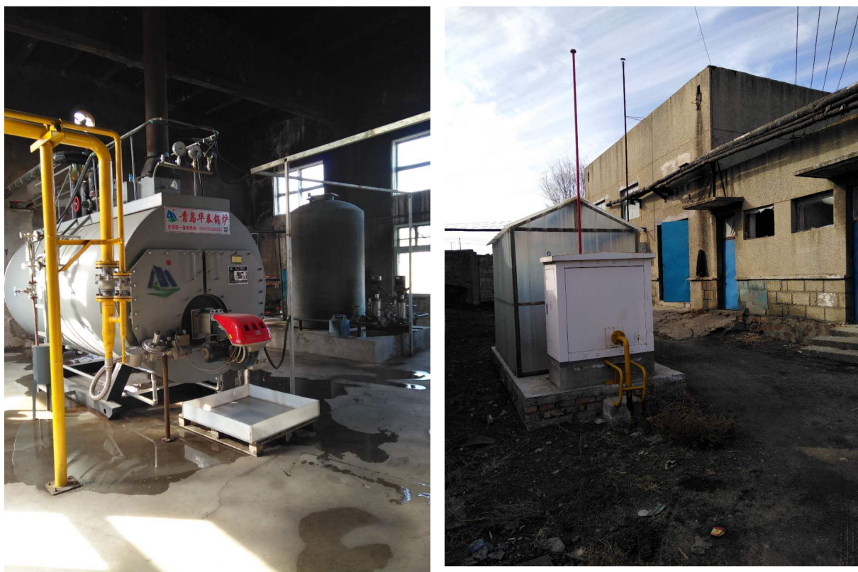
图 5.2-1 燃气锅炉及燃气调压站照片
